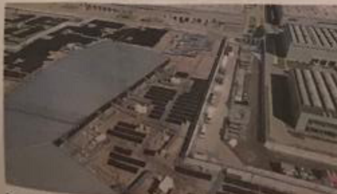
Ing, ad Ares fotovoltaico da 1,4 megawatt con 8.300 pannelli La bergamasca Ing, all'Ares Shopping Center, ha curato l'installazione del sistema fotovoltaico da 1,4 megawatt con 8.300 pannelli. Gabriele Ghilardi
