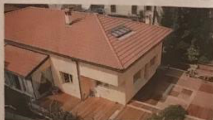
Edilizia sostenibile, la Vanoncini ha percorso i tempi La Vanoncini di Mapello ha scelto per prima il sistema a secco come perno fondante dell'attività. Sono cominciati a crescere i progettisti dell'edilizia sostenibile che rispetta l'ambiente.
