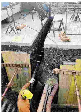
Una fase dei lavori per la posa dei tubi di trasporto dell'ossigeno, a Ciserano
